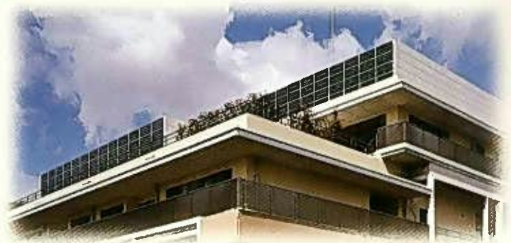
太陽光発電システム
